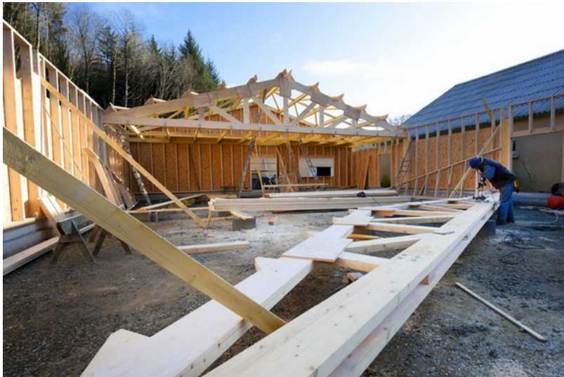
Chantier en février 2012 (© Hervé Ronné)
