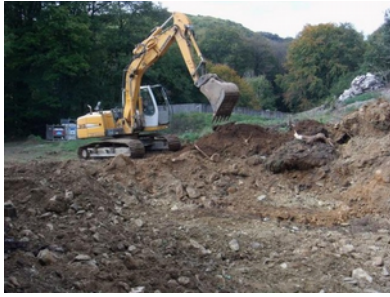
Travaux de terrassement (© Fédération de pêche du Finistère)
